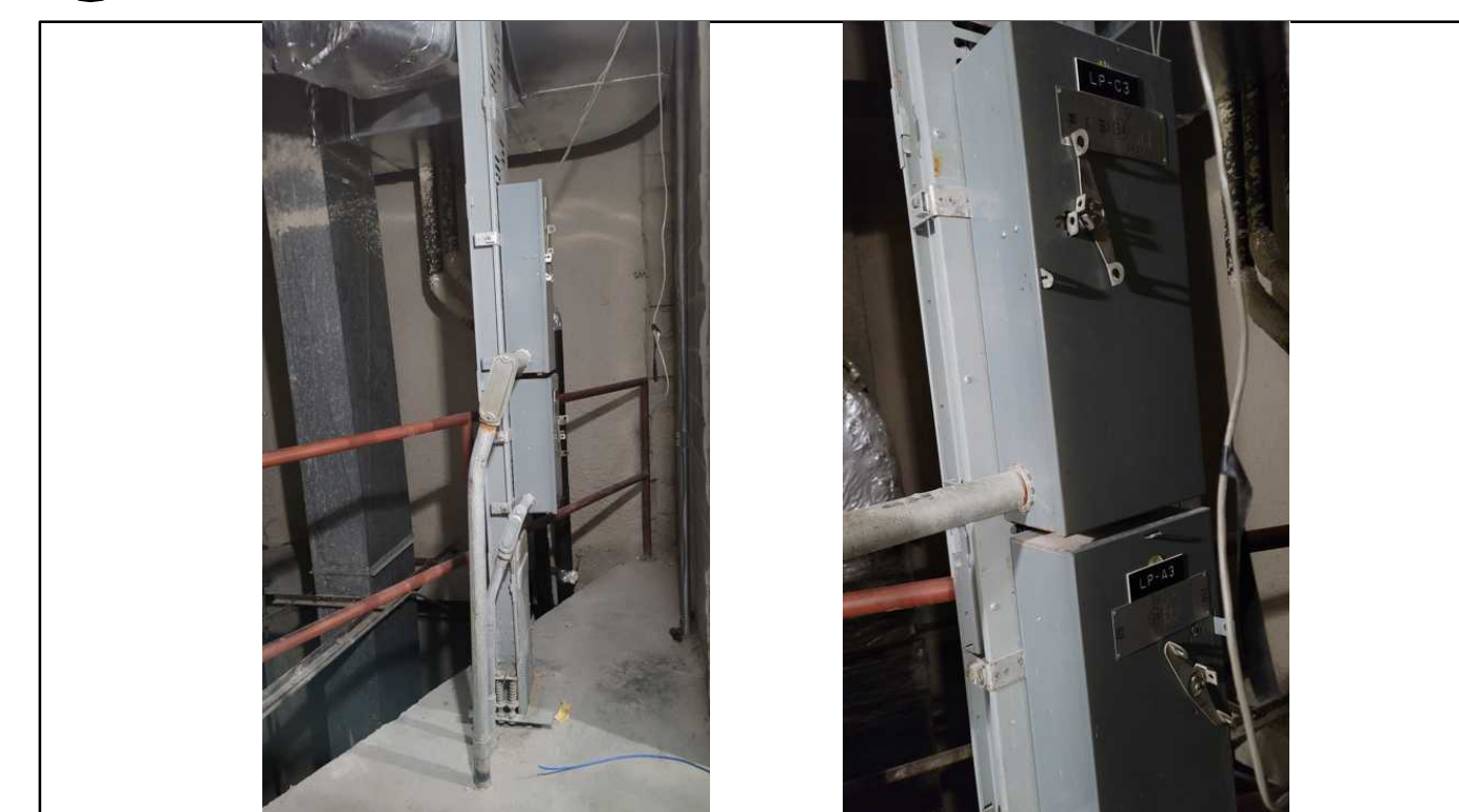
6 PHOTO OF EXISTING BUS PLUG SCALE: N.T.S.
